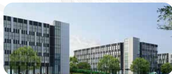
上海漕河泾开发区浦江高科技园生命健康产业园项目
