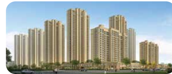
常州市武进区融创玉兰广场项目
